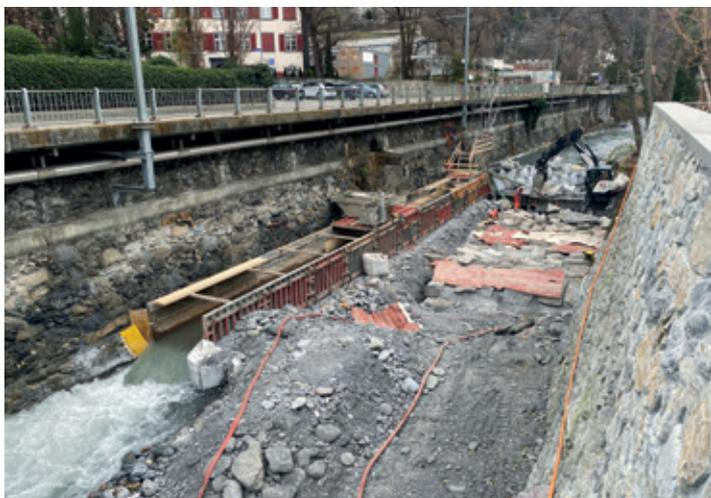
Wasserhaltung mit provisorisch erstelltem Kanal (links im Bild) und teilerstellte Blockrampe (rechts im Bild).
